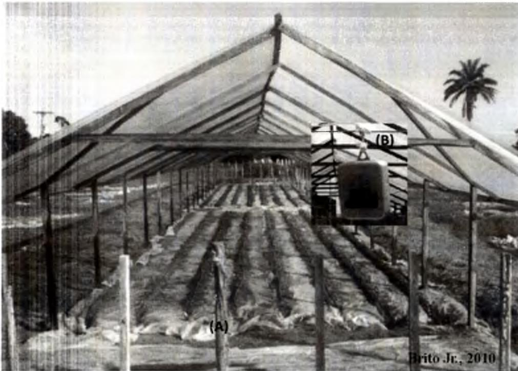
**Figura 2.** Casa de vegetação modelo capela adotada no experimento de cultivo protegido de tomateiro em substrato (A) e termohigrógrafo (B). Iranduba, AM, 2010.
