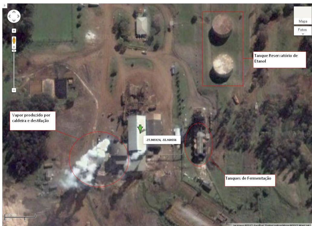
Figura 1. Feições espaciais da usina da Cooperativa dos Produtores de Cana de Porto Xavier, RS. Fonte: Google Maps
