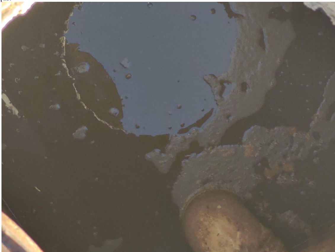
Figura 5 – Aspecto visual do esgoto sanitário afluente à etapa de tratamento de esgoto do protótipo instalado na Embrapa Hortaliças.
