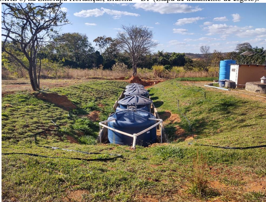
Figura 2 – Protótipo do Sistema ReAqua para atendimento a cerca de 300 pessoas funcionando em condições operacionais (TRL/MRL 6) na Embrapa Hortaliças, Brasília – DF (Etapa de tratamento de esgoto).
