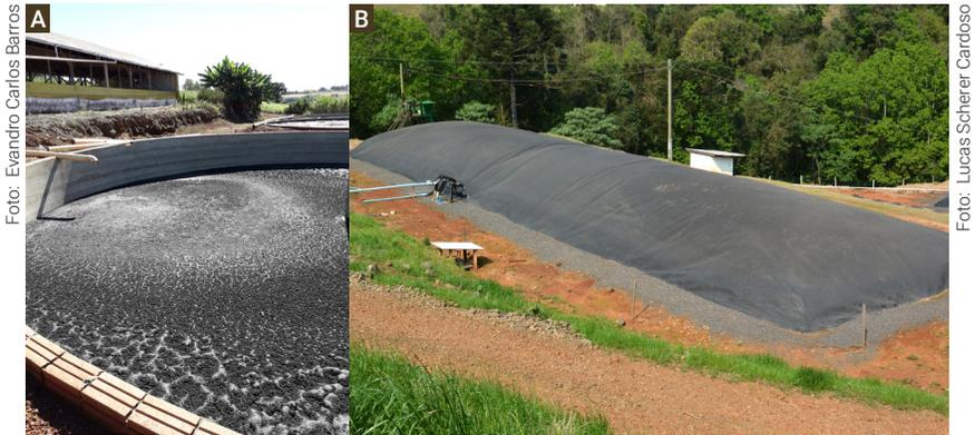
**Figura 1.** Esterqueira descoberta (A) e biodigestor (B) utilizados para armazenamento e estabilização de dejetos líquidos em unidades de produção de suínos do sul do Brasil.
