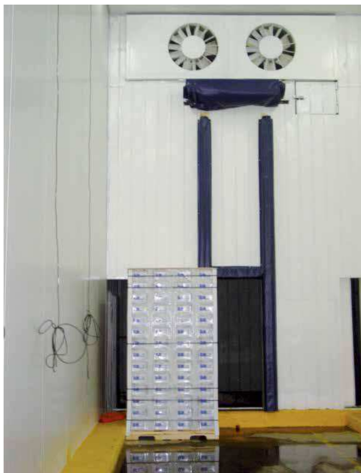
Figura 4. Aplicação do resfriamento rápido por ar frio forçado em morangos.
