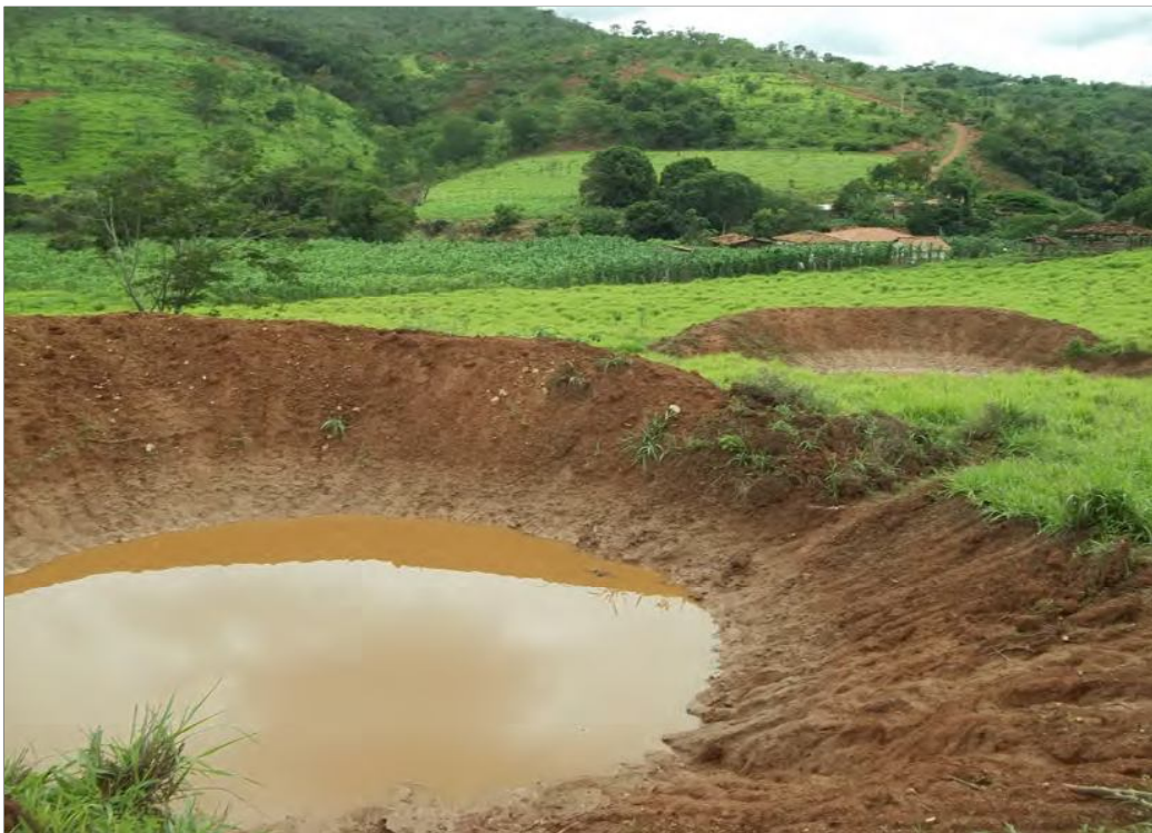
Barraginhas construídas no semiárido, em Minas Novas, MG. (Foto: Luciano Cordoval)
