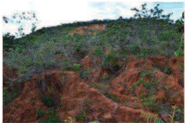
Figura 02. Vista da Voçoroca 02.
