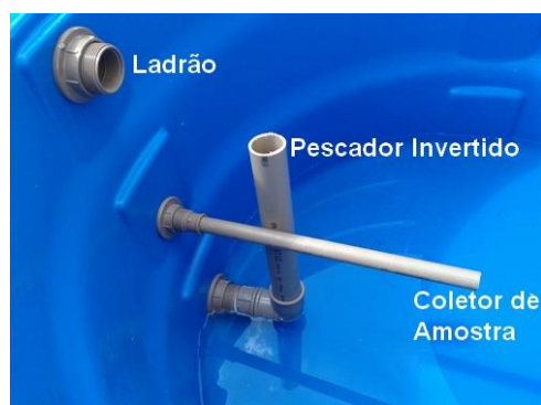
Figura 2 – Esquema interno dos reservatório 4, 5 e 6.
