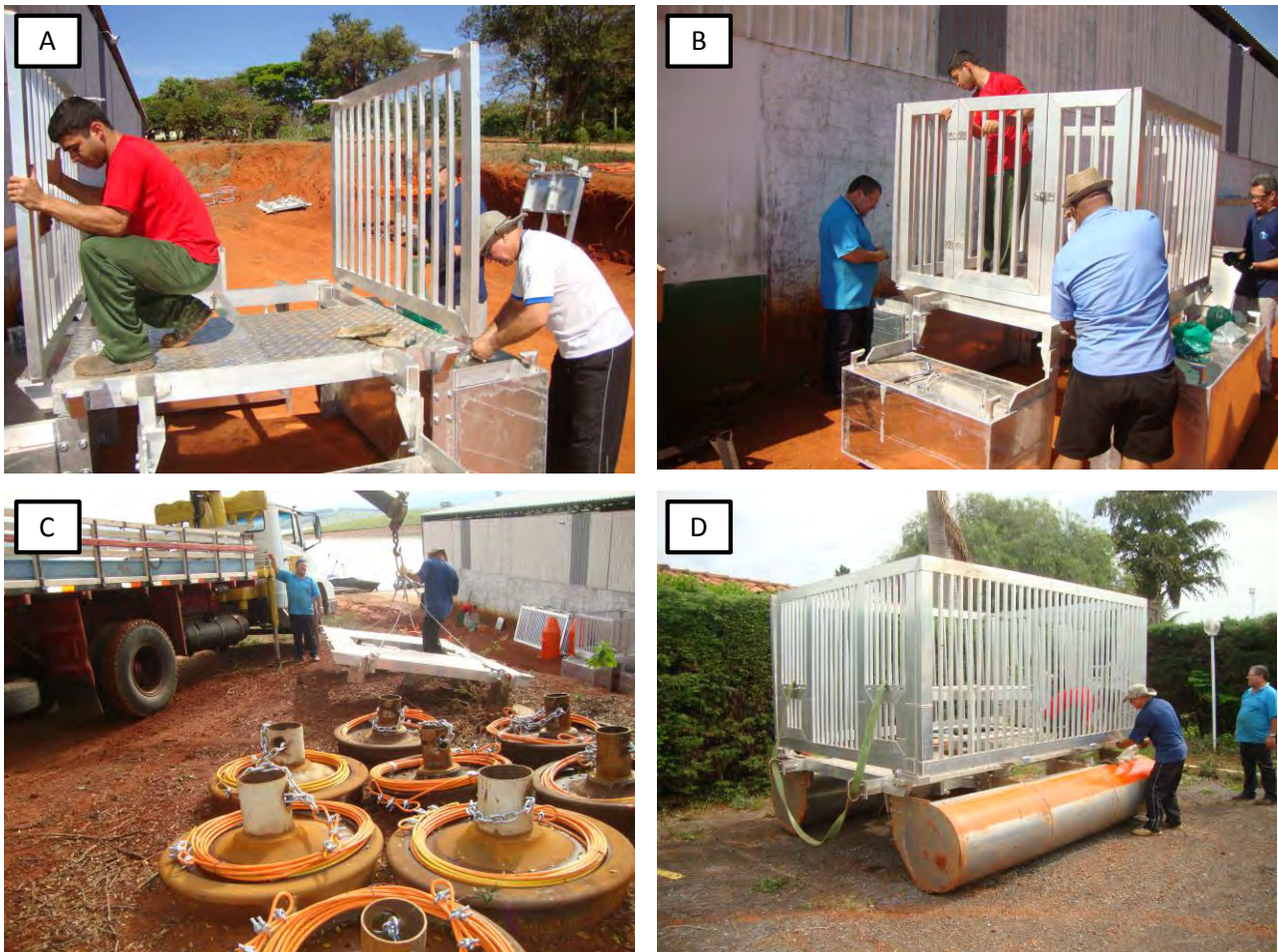
Figura 2 A a D: A e B – Sistema secundário sendo montado C - Ancoras para sustentar os sistemas nos pontos de fundeio; D – Sistema principal sendo montado.
