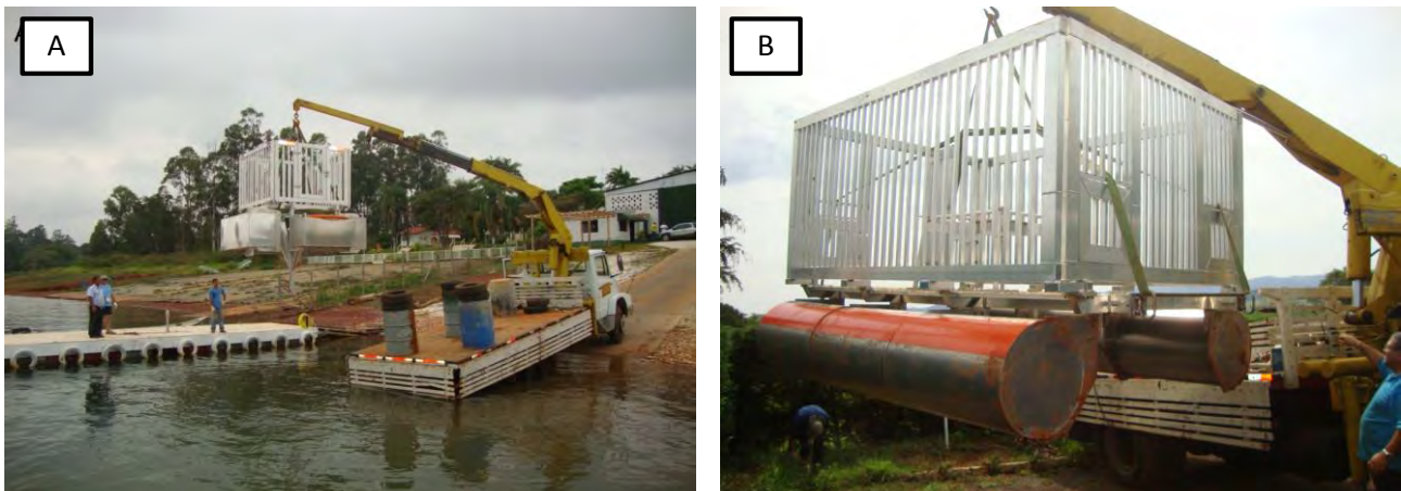
Figura 3 A e B: Plataformas Secundárias (A) e Principal (B) parcialmente montadas e manipuladas por caminhão dotado de Munck.
