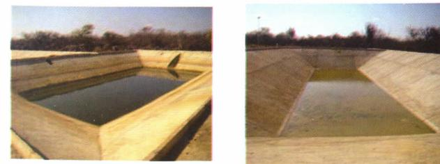
Figura 7: Lagoas de estabilização para tratamento do esgoto da Unidade.
