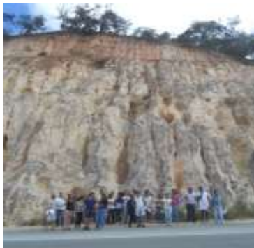
Figura 2- Embasamento cristalino alterado. Jun/2014.
