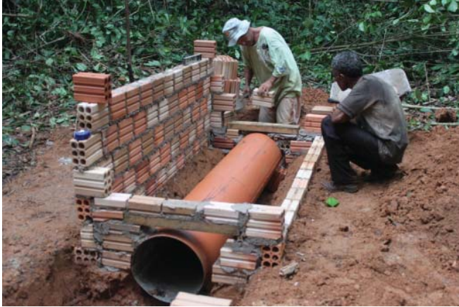
Figura 7. Assentamento do trocador de calor.
