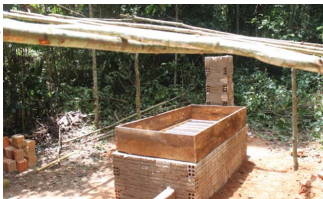
Figura 12. Assentamento da câmara de secagem.
