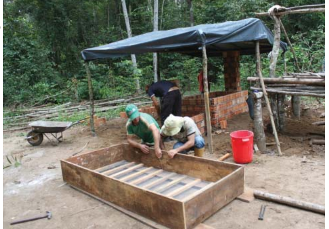
Figura 10. Construção da câmara de secagem.
