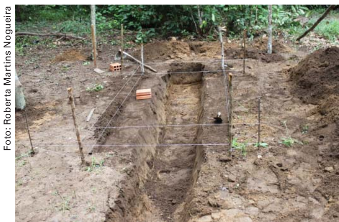
Figura 5. Marcação e escavação do terreno.
