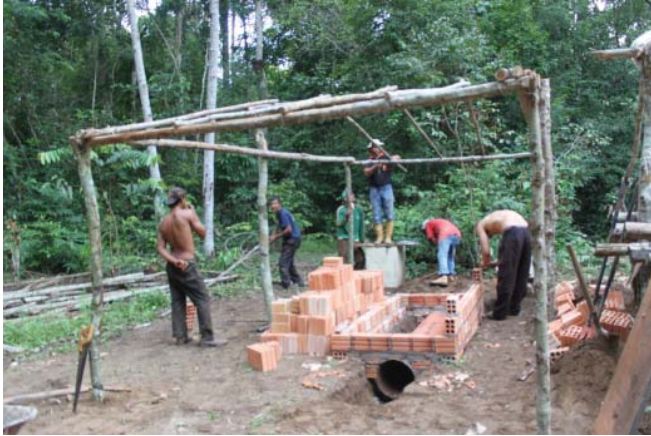
Figura 6. Execução da alvenaria – câmara plenum.
