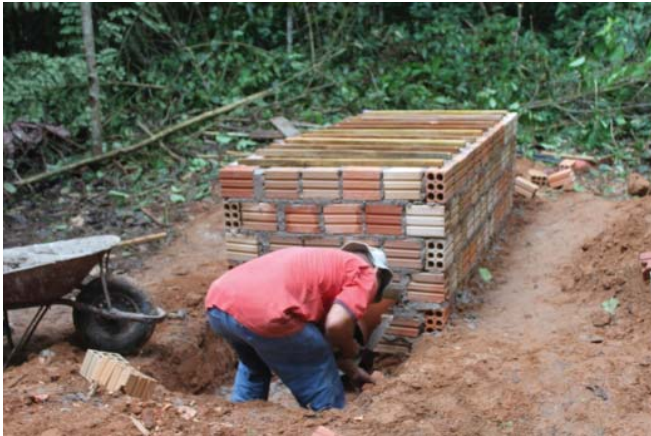
Figura 8. Execução da alvenaria – fornalha.
