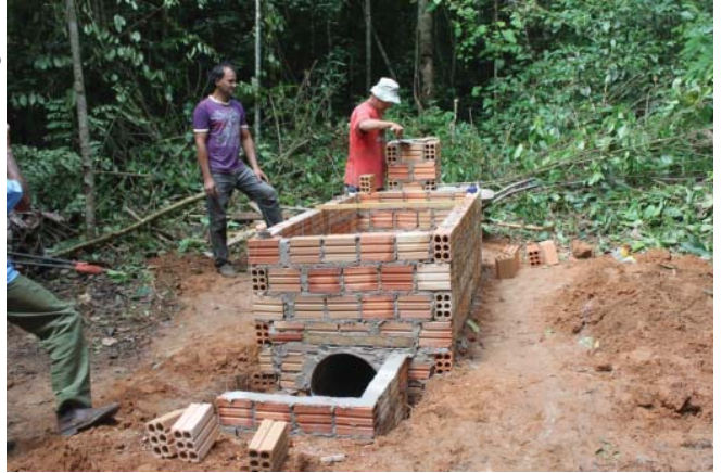
Figura 9. Execução da alvenaria – chaminé.
