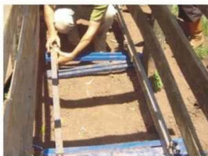
Figura 3. Colocação das vigas laterais e centrais, sobre as barras de pesagem.
