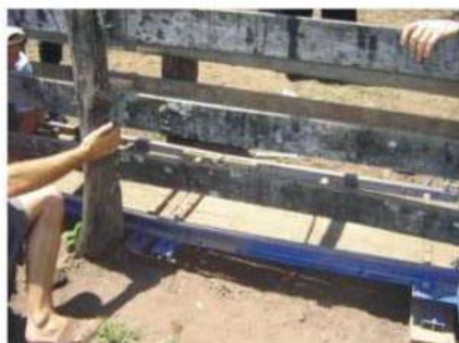
Figura 5. Ajuste das vigas e aperto dos parafusos de fixação.
