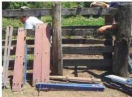
Figura 1. Vão de 30 cm entre a última tábuia do brete e o piso, necessário para colocação das barras de pesagem.
