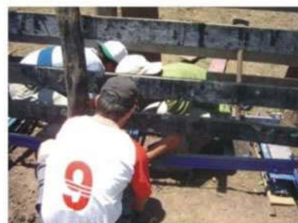
Figura 4. Fixação das vigas centrais com parafusos.
