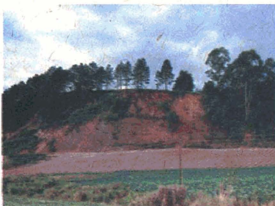
Foto 18. Aterro da várzea.
