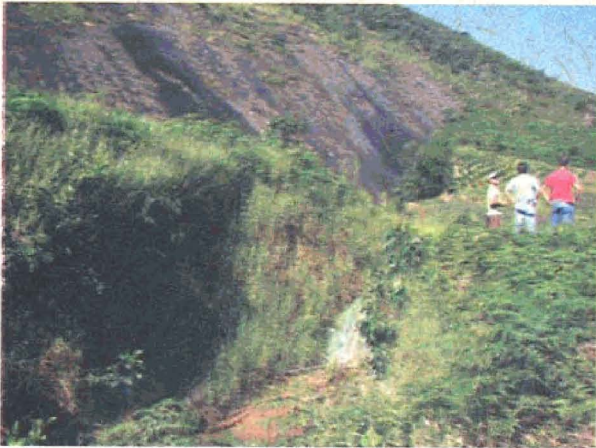
Foto 2. Bacia de retenção.
