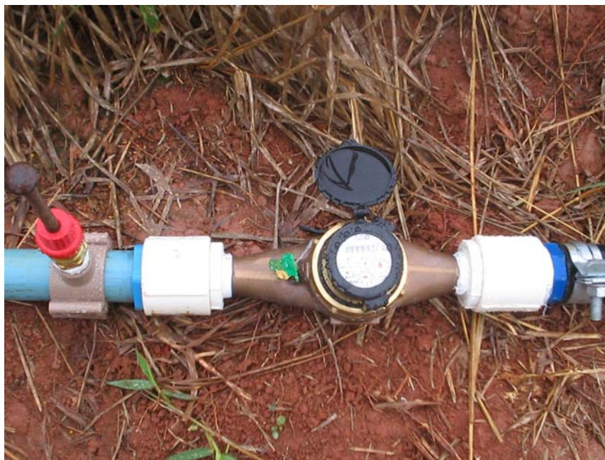
Figura 26 – Hidrômetro utilizado para registro dos volumes de água aplicados.
