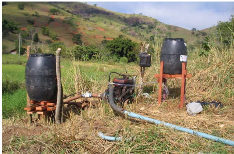
Figura 22 - Detalhe do sistema de bombeamento e dos tanques de fertirrigação.
