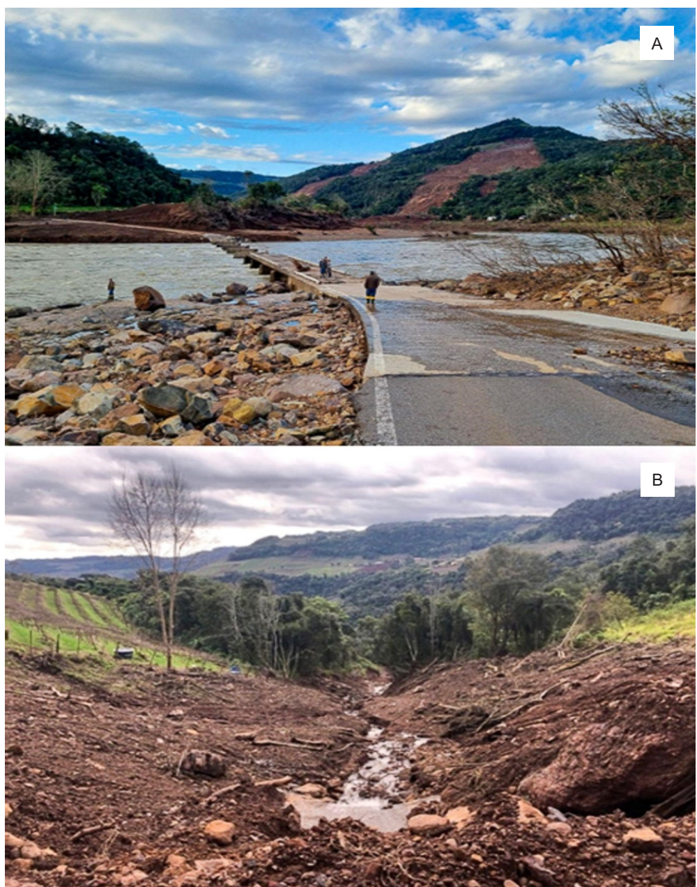
Figura 4.5. Ponte quase totalmente destruída, com afloramento de pedras e acúmulo de sedimentos nas margens do rio. Ao fundo, é possível ver a encosta extensa com áreas desmatadas e solo exposto, sugerindo deslizamentos intensos. (A) Árvores arrancadas e acúmulo de sedimentos próximos à margem indicam que o evento foi de alta energia, causando danos à vegetação e infraestrutura local; (B) Danos verificados devido aos deslizamentos de alta intensidade em zonas de convergência hídrica na paisagem e afetando propriedades rurais com viticultura.
