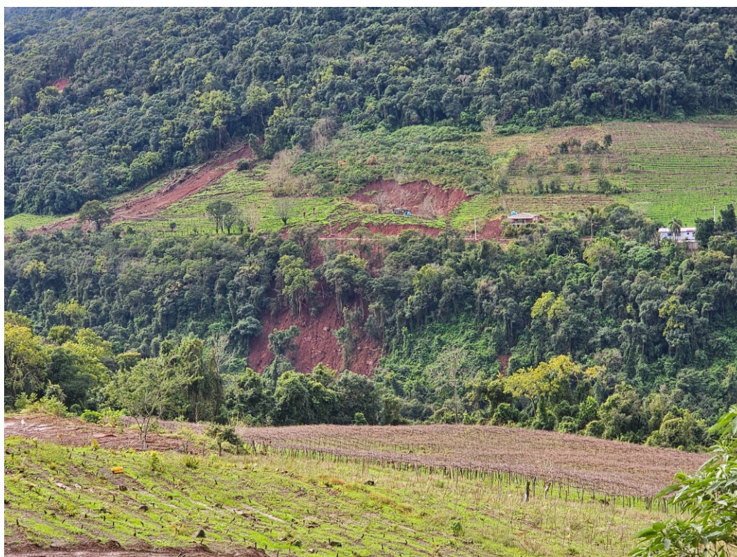
Figura 3.14. Plotação de estrada ao final da rampa coluvionar, muito próxima à rampa erosional à jusante.
