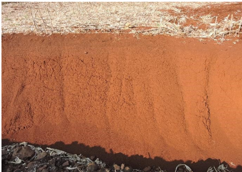
Figura 3.9. Talude de estrada com aspecto rendilhado com caneluras em Nitossolo Vermelho.
