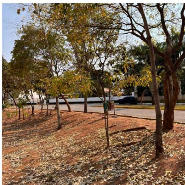
Figura 4. Árvores localizadas na beira do asfalto, com suas raízes expostas.
