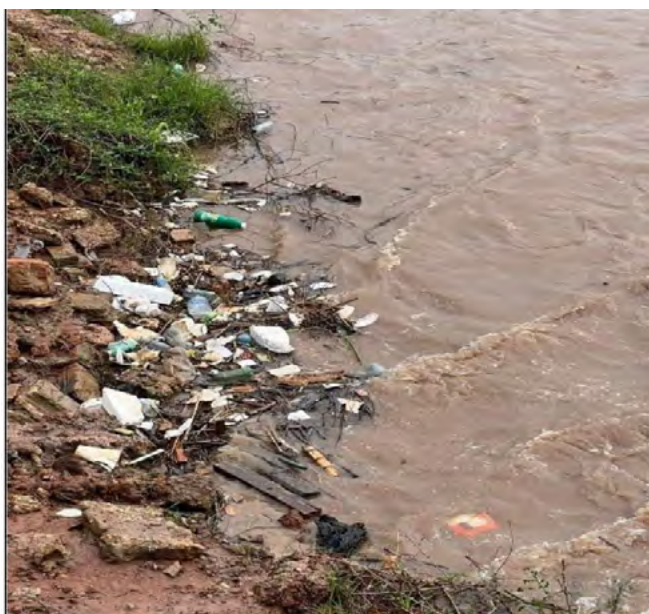
Figura 5. Resíduos sólidos encontrados na margem da galeria pluvial.
