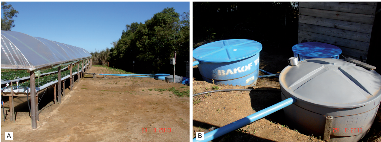
Figura 15. Tanques reservatórios de solução nutritiva e de água.
