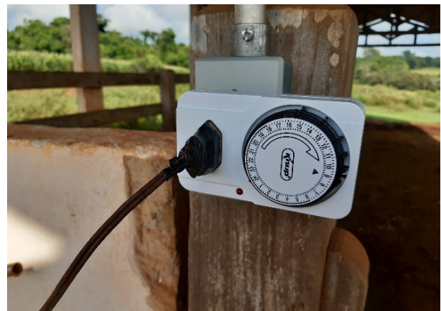
Figura 19. Temporizador mecânico.
