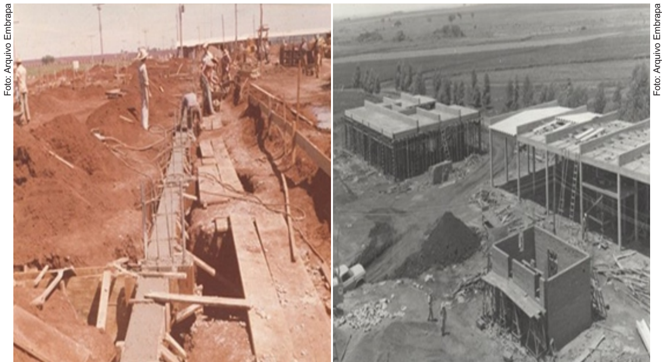
Figura 7. Vista parcial do canteiro de obras, na construção da sede própria da Unidade de Execução de Pesquisa de Âmbito Estadual (Uepae) de Dourados, em Dourados, MS, em 1978.
