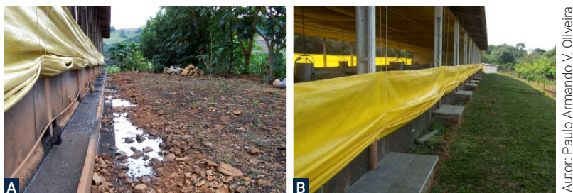
Figura 2. Calhas coletoras de dejetos abertas e com transbordamento (A) e sistemas fechados onde o flush é utilizado para limpeza das calhas (B).
