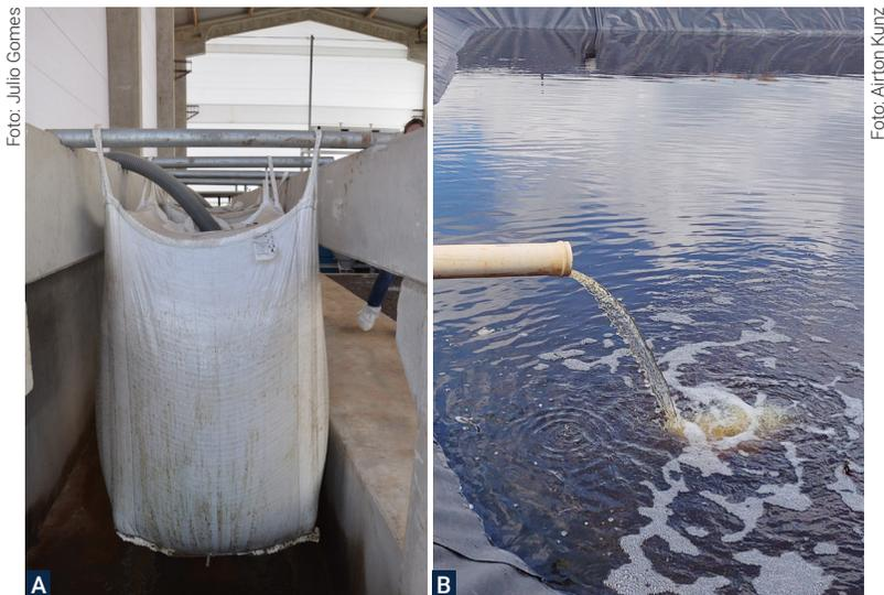
**Figura 2.** A) Imagem de bag de rafia com lodo da precipitação química de P durante o deságue. B) Imagem do efluente final do processo (saída, sobrenadante do decantador).
