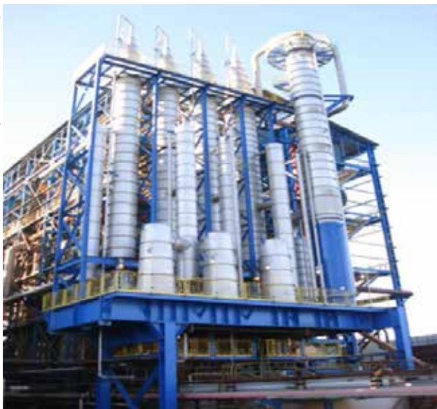
Figura 10.21. Visão geral do concentrador de vinhaça com integração energética (Grupo Raízen – Unidade Costa Pinto, Piracicaba, SP).
