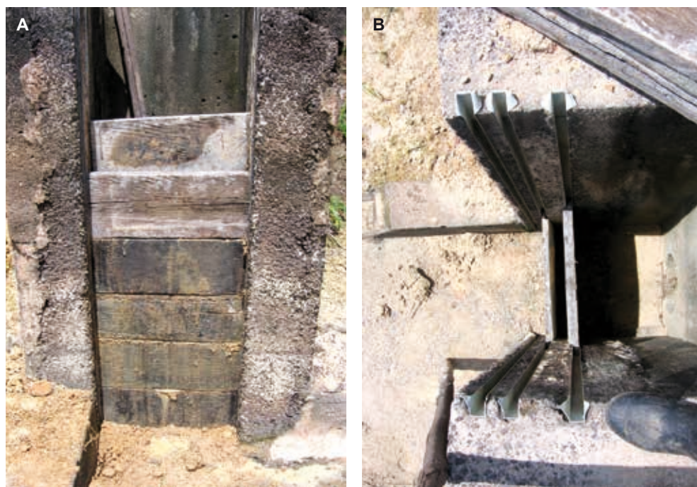
Figura 8. Sistema de drenagem tipo monge: (A) canaletas para controle de nível e renovação de água; (B) três canaletas verticais utilizadas para manter o nível de água e realizar a drenagem do viveiro.
