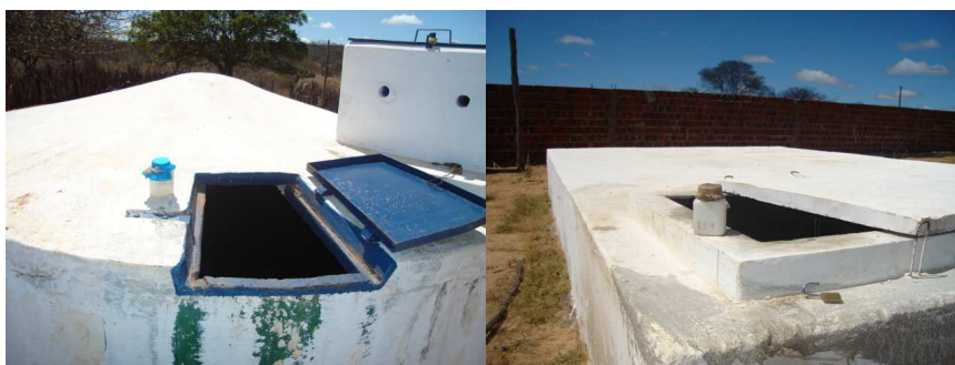
Figura 1. P2: Cisterna de placas e P3: Reservatório apoiado de alvenaria
