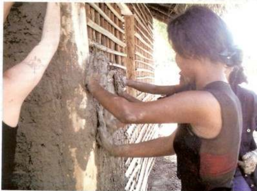
CONSTRUÇÃO SUSTENTÁVEL. Mão-de-obra e produtos locais reduzem gastos de energia e emissão de poluentes
