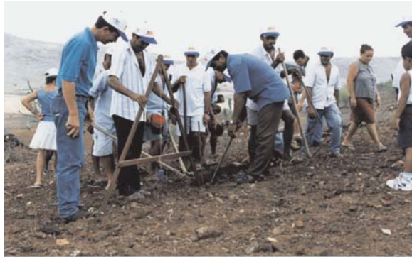
Fig. 2. Pé-de-galinha em operação. O nível é de cimento.
