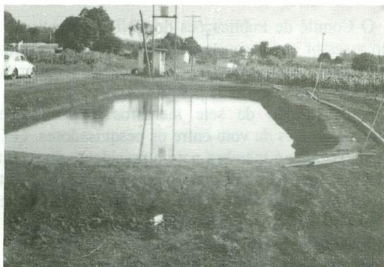
**FIGURA 101.** Tanque impermeabilizado com lona de plástico em operação.
