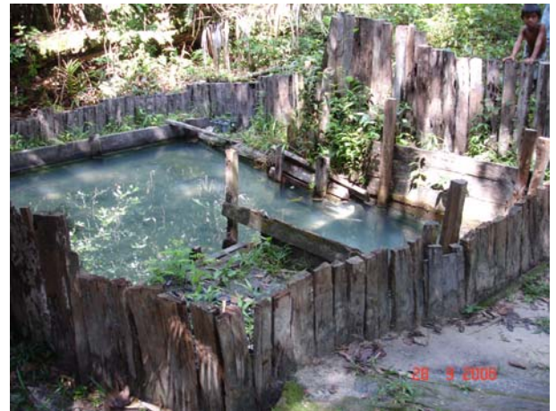
Figura 48: Barragem construída num igarapé para auxiliar na criação de peixes e para amolecer a mandioca
