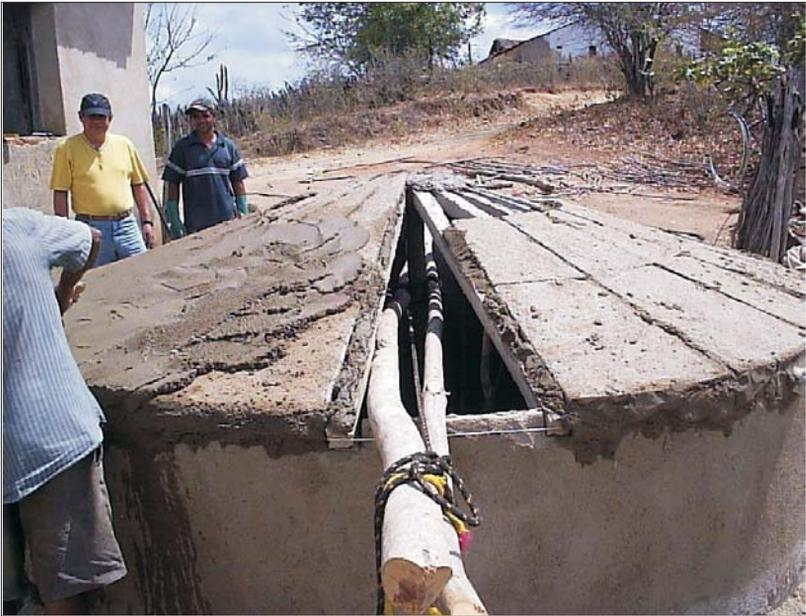
Foto 7 – Detalhes da Montagem da Tampa da Cisterna
