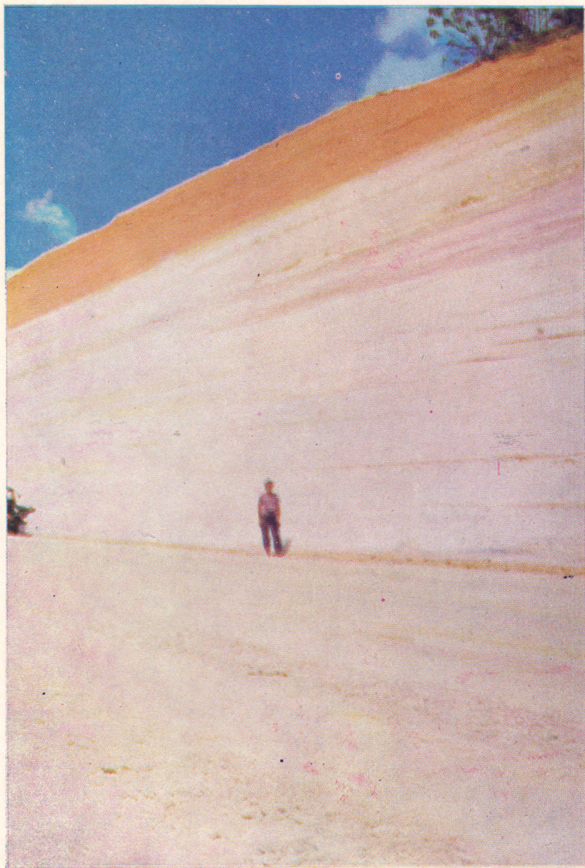
Corte de estrada indicando um perfil de Latosol Amarelo textura muito pesada e o material originário constituído de sedimentos argilosos cauliniticos
