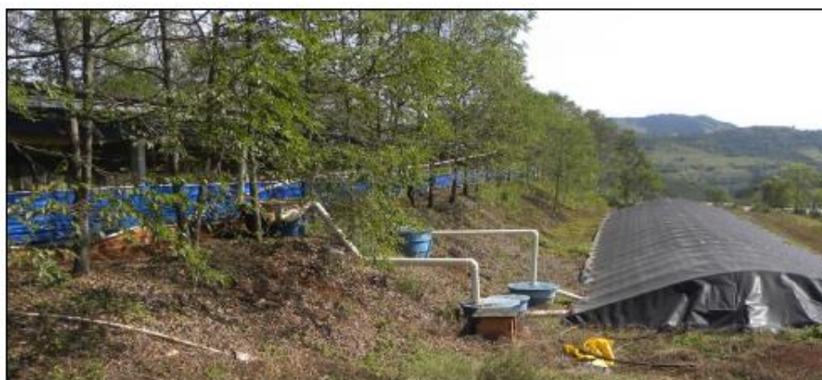
Figura 3. Sistema completo de captação em telhados, com separador de primeira água, filtro e cisterna.
