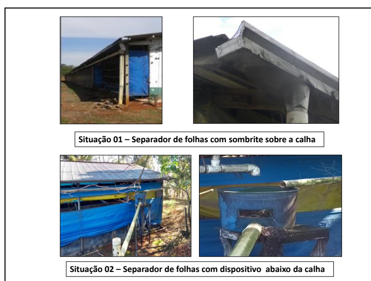
Figura 4. Dispositivos utilizados como separadores de folhas no sistema de captação. Fonte: acervo do Comitê Jacutinga.
