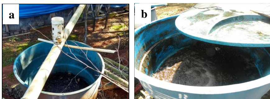
Figura 5. a) Dispositivo de desvio da primeira água da chuva operado incorretamente; b) dispositivo de descarte de sólidos (pré-filtro) operado incorretamente. Fonte: acervo do Comitê Jacutinga.
