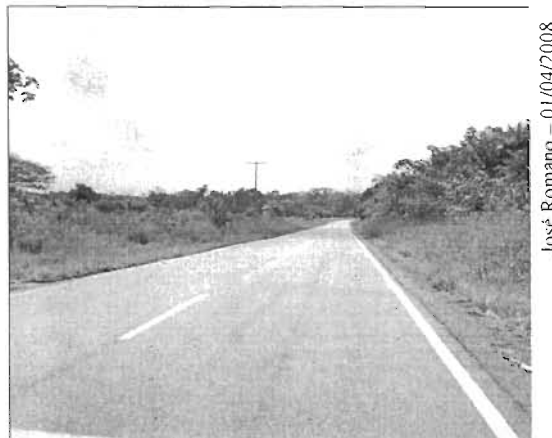
Figura 8- Rodovia estadual PA 253 - Rodovia da Laranja
