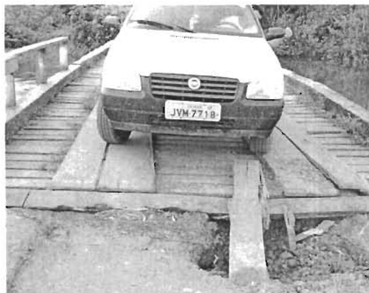
Figura 53- Condições de algumas pontes
