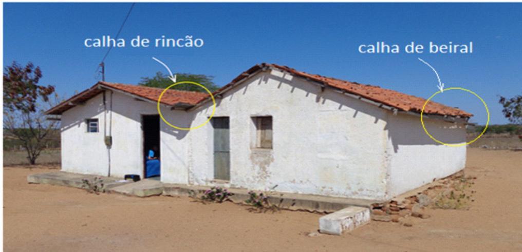
Figura 6. Telhado geminado com calha de rincão e calha de beiral
