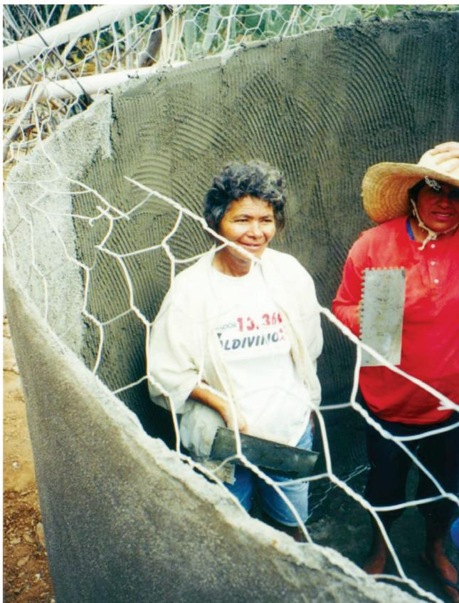
Figura 23. Construção de cisterna de concreto com tela de arame
