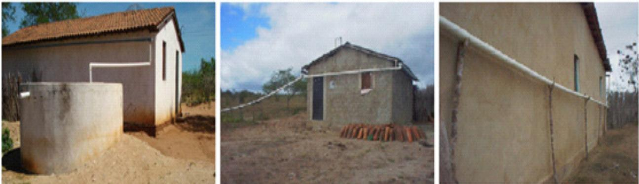
Figura7. Condutores suspensos expostos a intempéries, fixados por meio de suportes improvisados
