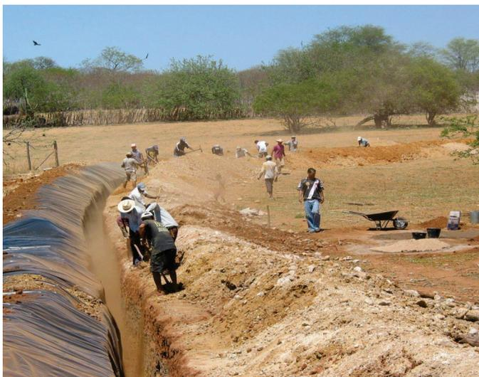
Figura 27. Barragem subterrânea, colocando a lona de PVC
