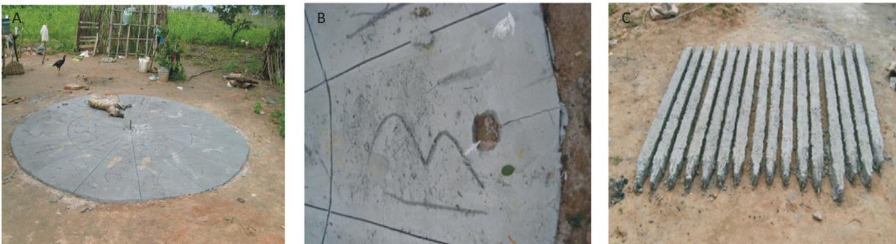
Figura 9. Moldagem das placas de cobertura e caibros
