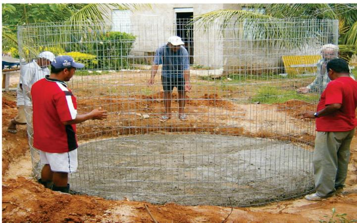
Figura 24. Cisterna de alambrado
