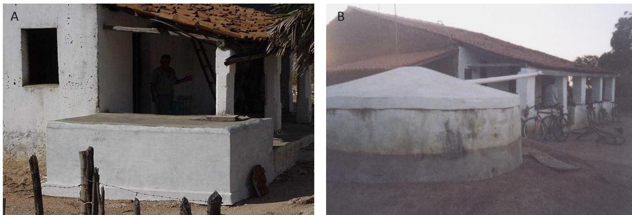
Figura 3. Modelo de cisterna rural antes do P1MC (A); Modelo de cisterna rural do P1MC (B)
