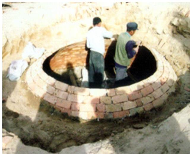
Figura 4. Os agricultores construíram as cavernas d' água por conta própria
