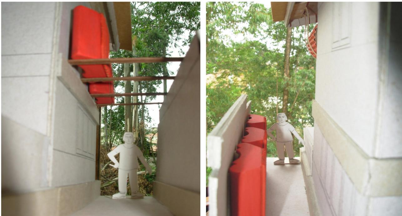
Figura 6. Sugestões de posicionamento de reservatórios modulares esbeltos para aproveitamento de água de chuva para uso externo em edificações existentes em meio urbano
