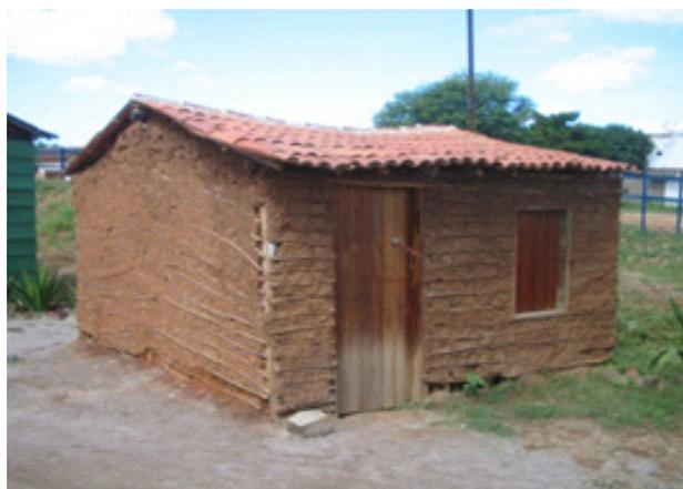
Figura 2. Casebre de taipa com telhado pequeno e deformado
