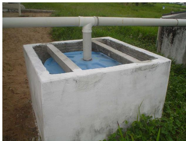
Figura 9. Fotos do dispositivo de desvio automático de desvio do primeiro milímetro, LARHISA da UFRN, em Natal
