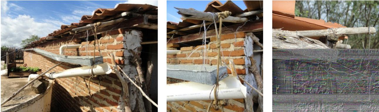
Figuras 10, 11 e 12. Improvisação de suportes de calhas e condutores com materiais inadequados
