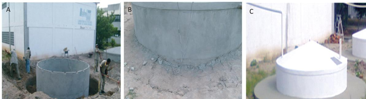
Figura 12: Aterro lateral da cisterna: (A) enchimento; (B) erosão devido à má compactação; (C) calçada lateral
