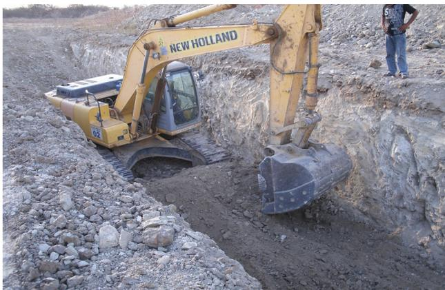
Figura 29. Barreiro trincheira (a máquina escavadeira hidráulica retira a segunda camada, até chegar à profundidade de quatro metros)
