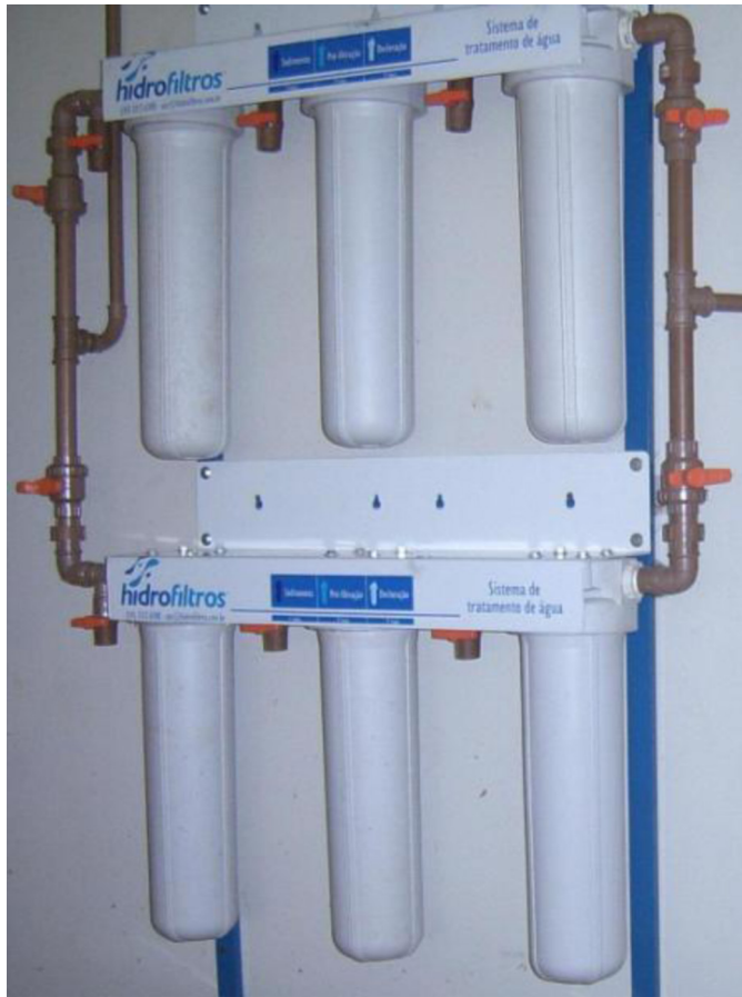
Fig.1. Filtro HF 5000 constituído por elementos filtrantes Big 5 HPC 10'' big; Big 50 PF 10'' big, Hidrofiltros®, utilizado durante o experimento.
