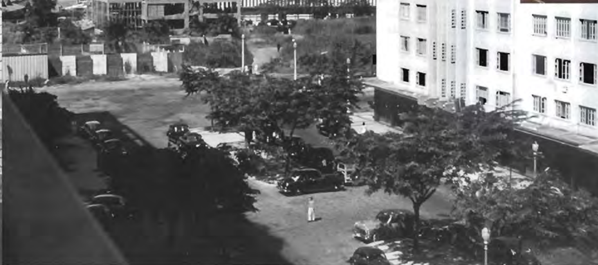
Vista parcial do edifício à Rua 1ª de Março nº 15, onde a SNA funcionou de 1912 a 1935.
